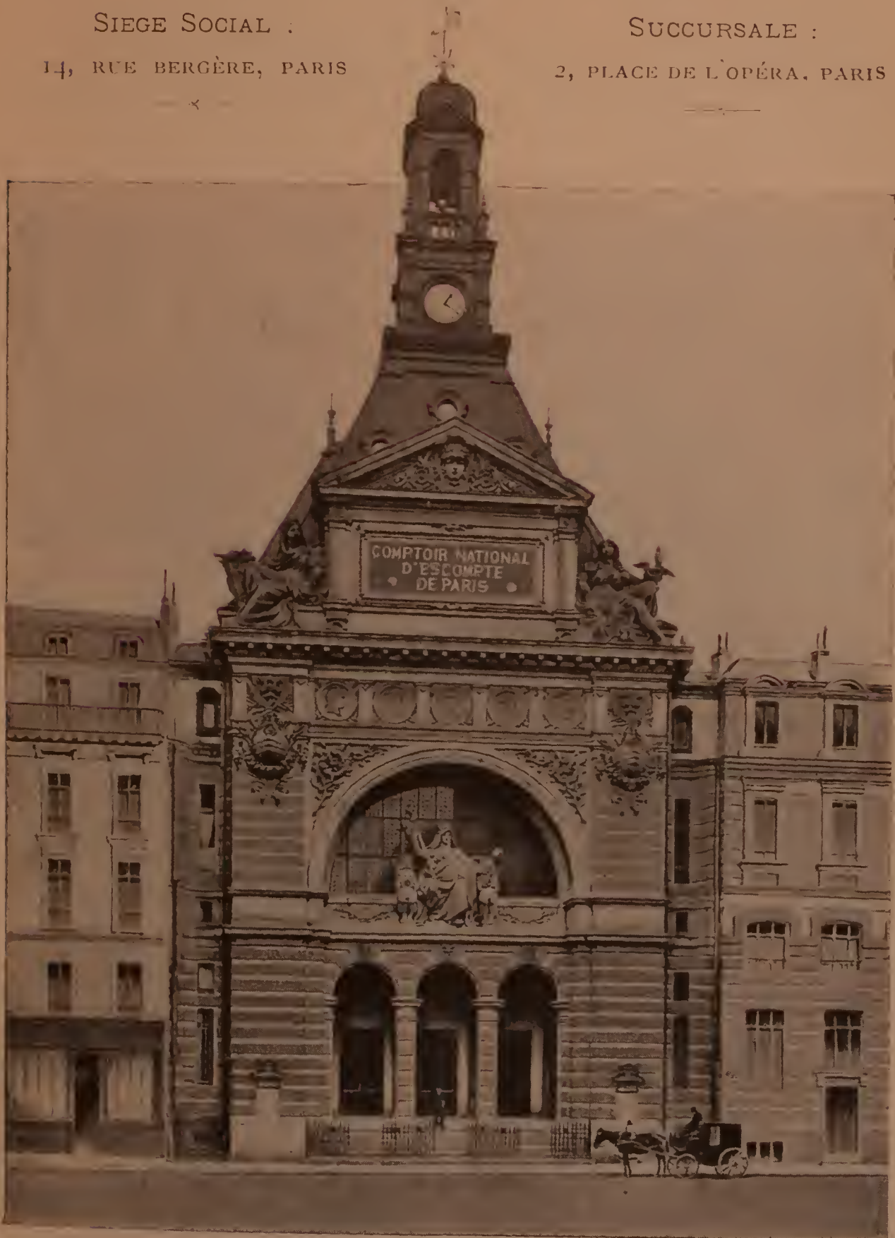
La façade du Siège Social, 14, rue Bergère Paris.
